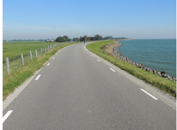
DE DIJK TUSSEN SCHELLINKHOUT EN OOSTERLEEK
