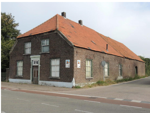
LANGGEVELBOERDERIJ HOEK MAASSTRAAT
